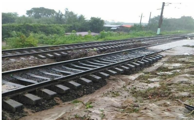
3-расм. Намлик ошиши натижасида ер полотносини зарарланиши.
