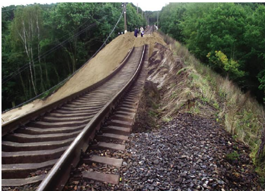
2-расм. Ер полотносида кўчкининг ҳосил бўлиши.
